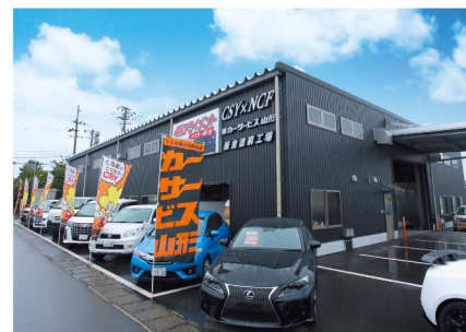
NCF钣金塗装工場
